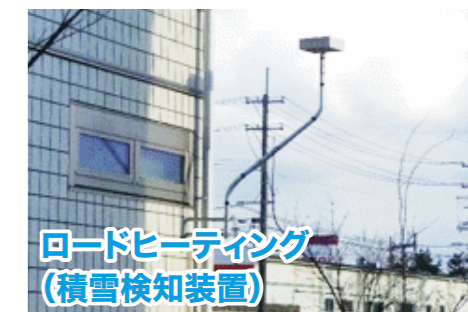
電力会社電気ビルB ロードヒーティング積雪検知器
